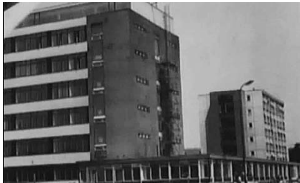
Obr. 1. Výstavba výzkumného ústavu a administrativní budovy
